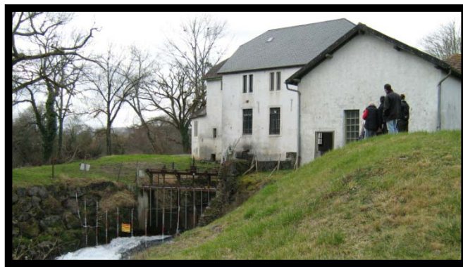
A l'aval, l'eau turbinée est rejetée dans le Saison. Une installation électrique empêche les poissons de s'approcher du bâtiment
