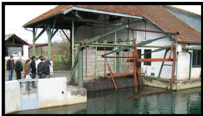
Le canal d'arrivée d'eau et les grilles empêchant les feuilles et les branches de « passer » dans la turbine
